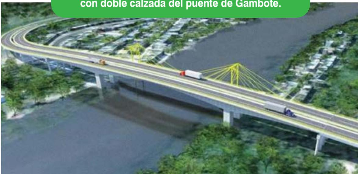
El nuevo puente de Gambote será de concreto reforzado y tendrá una longitud aproximada de 627 metros.
