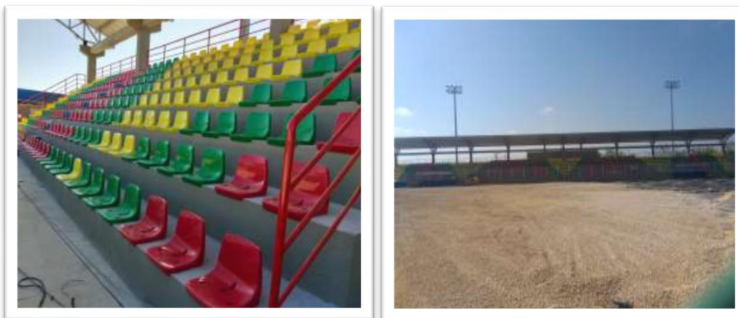
Imágenes No.86. Imágenes y evidencias del avance construcción de cancha de fútbol EM San Estanislao de Kostka
