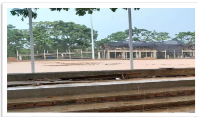
Imágenes No.83. Imágenes y evidencias del avance unidad deportiva en el corregimiento de Tierra Firme municipio de
