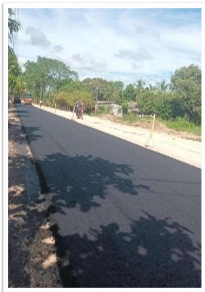
Imágenes No.88. Imágenes y evidencias del avance del Mejoramiento en concreto asfaltico de la vía que comunica al municipio de Hatillo de Loba con el corregimiento de Botón de Leiva.
