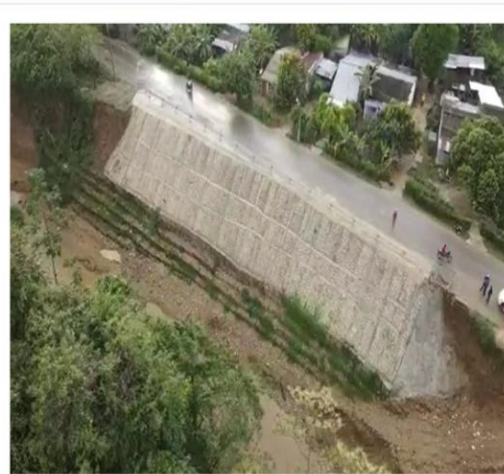
Imágenes No.50. Evidencias fotográficas de la Construcción de obras de protección en el talud izquierdo de la vía que comunica los corregimientos de Malagana y Palenque en el municipio de Mahates
