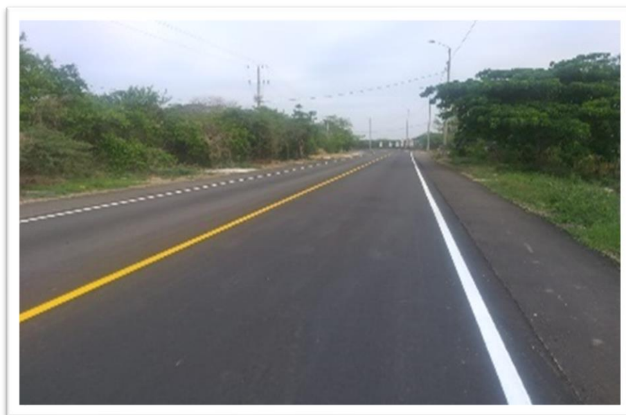
Imágenes no.71. imágenes y evidencias rehabilitación de la vía que comunica, el corregimiento de Punta Canoa y la vereda Manzanillo del Mar
