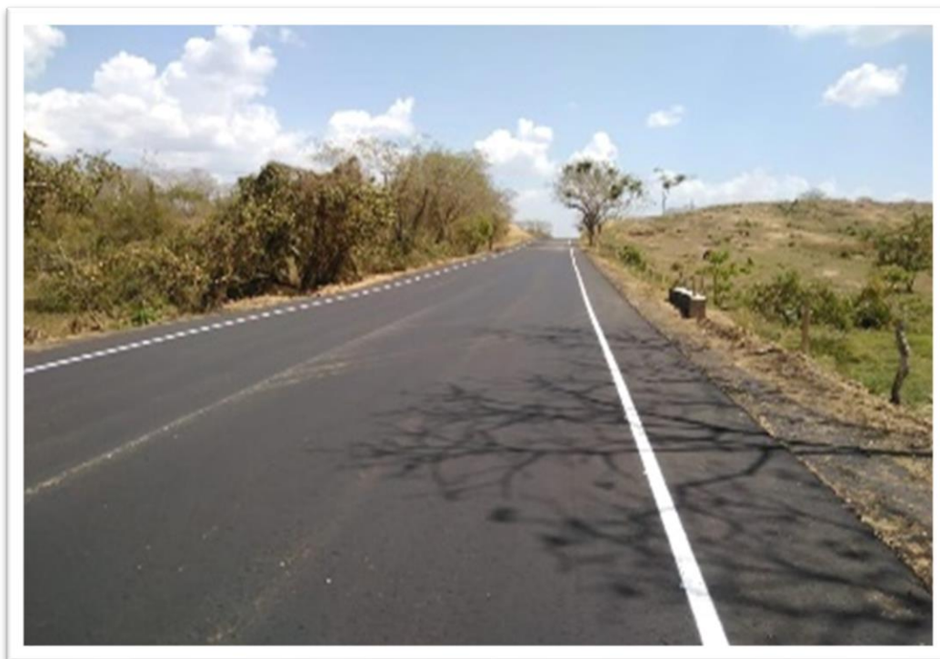
Imágenes no.70. imágenes y evidencias del mejoramiento en concreto asfáltico de la vía que conduce del municipio de Arroyohondo a la intersección con la ruta nacional 25 en el municipio de Calamar
