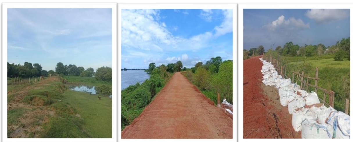
Imágenes No.56. Evidencias fotográficas de obras de mitigación para atención de emergencia en el corregimiento de Retiro y puntos críticos en el jarillón Guazo- Retiro, en el municipio de Magangué, Departamento de Bolívar FUENTE: OGRD
