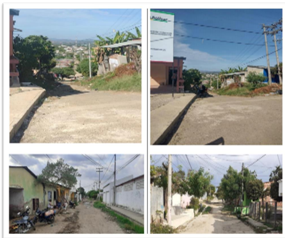
Imágenes No.90. Imágenes y evidencias del avance Mejoramiento en concreto rígido de la calle 26 del municipio del Carmen de Bolívar.
