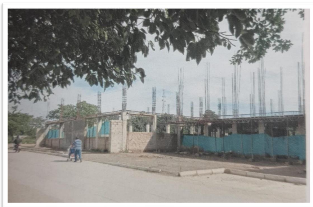
Imágenes No.84. Imágenes y evidencias del avance construcción de subsele multisectorial SENA en el municipio de Magangué
