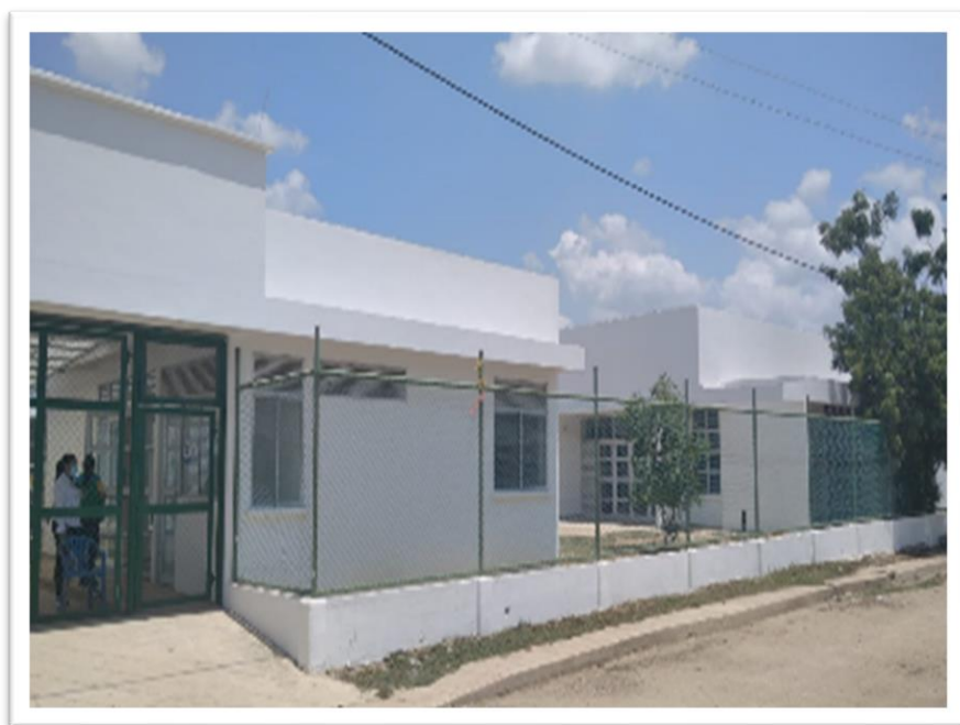
Imágenes No.86. Imágenes y evidencias del avance en la construcción de los CDI.
