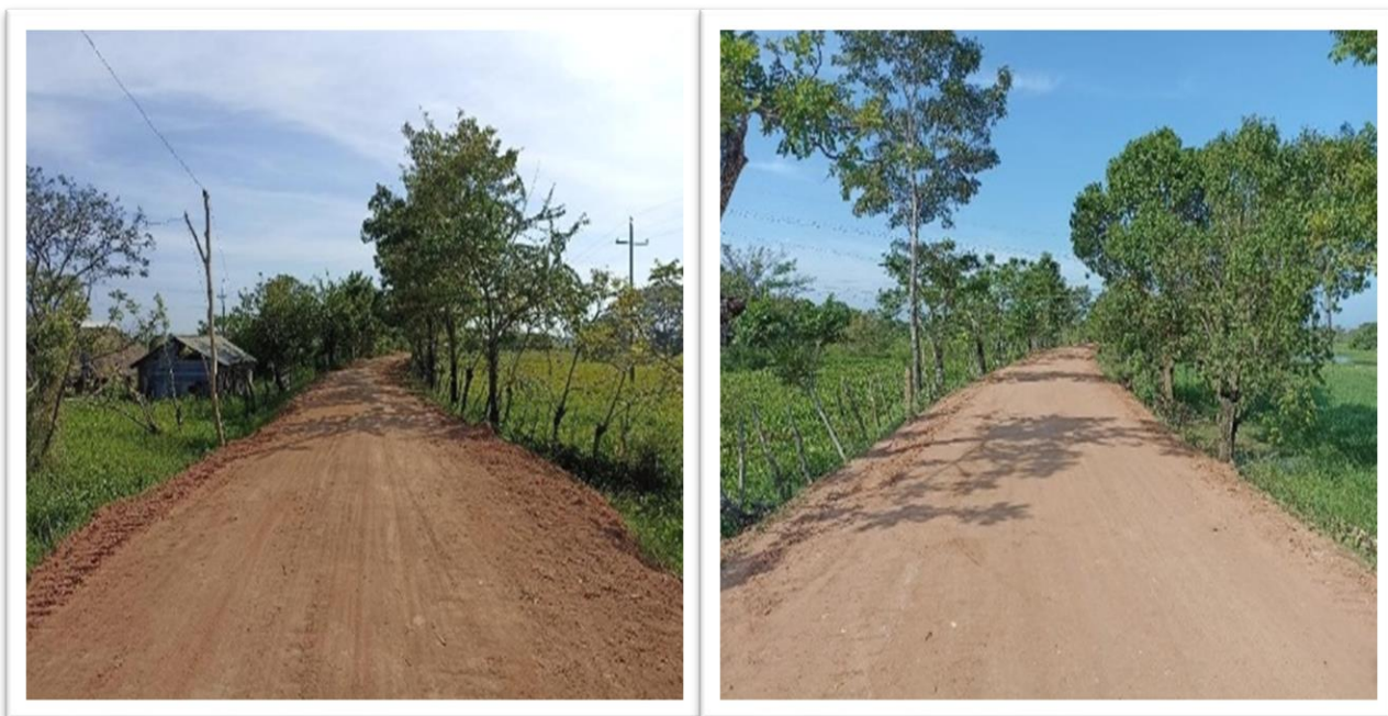
Imágenes no.59 Evidencias fotográficas de obras de mitigación para la atención de emergencia en puntos críticos y mejoramiento de rasante del jarillón entre los corregimientos de Retiro y Madrid en el en el municipio de Magangué,
