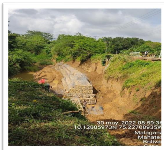
Imágenes No.50. Evidencias fotográficas de la Construcción de obras de protección en el talud izquierdo de la vía que comunica los corregimientos de Malagana y Palenque en el municipio de Mahates
