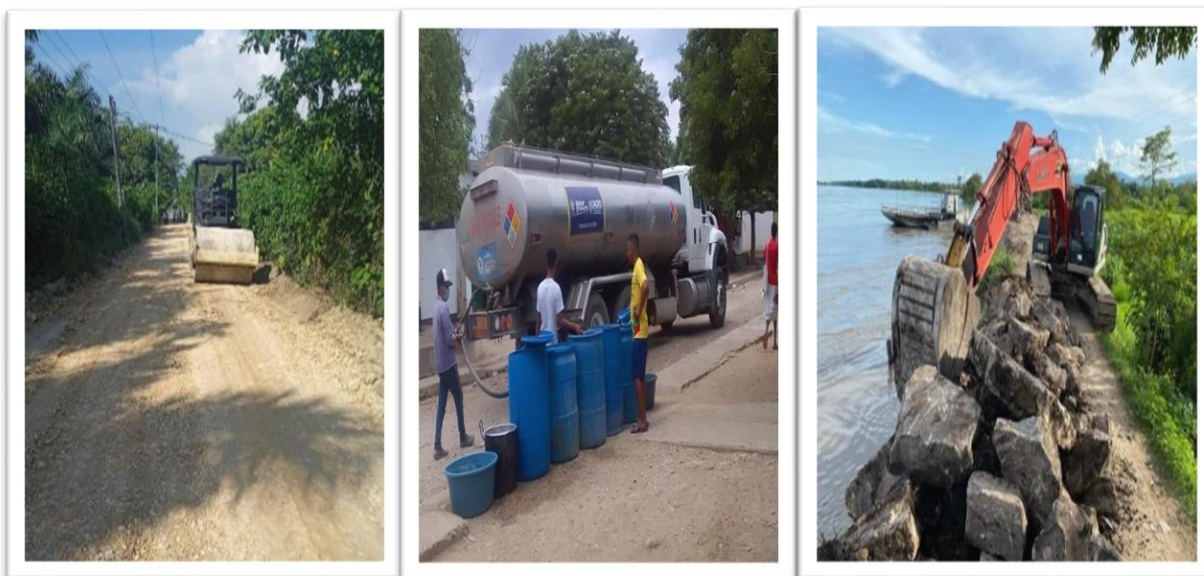
Imágenes No.52. Evidencias fotográficas de la Intervención por parte de la OAGRD con horas maquina: Reforzamiento de Jarillón, Recuperación ambiental de humedales, Adecuación hidráulica de cauce, Rehabilitación de vías terciarias, reforzamiento de jarillones y estabilidad de taludes, limpieza de canal, suministro de carro tanque de agua, extracción y cargue de material de relleno. FUENTE: OGRD
