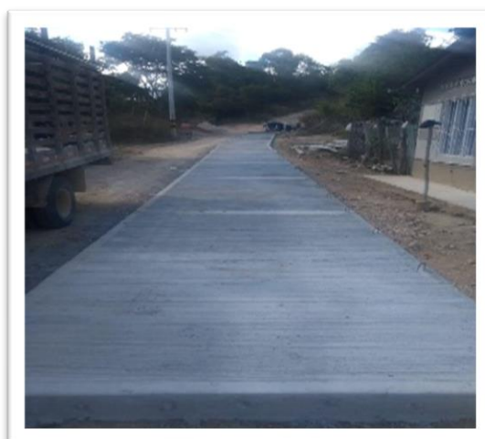
Imágenes No.69. imágenes y evidencias del mejoramiento de la vía terciaria que comunica el municipio de San Jacinto con el corregimiento de las Palmas FUENTE: Secretaría de Infraestructura
