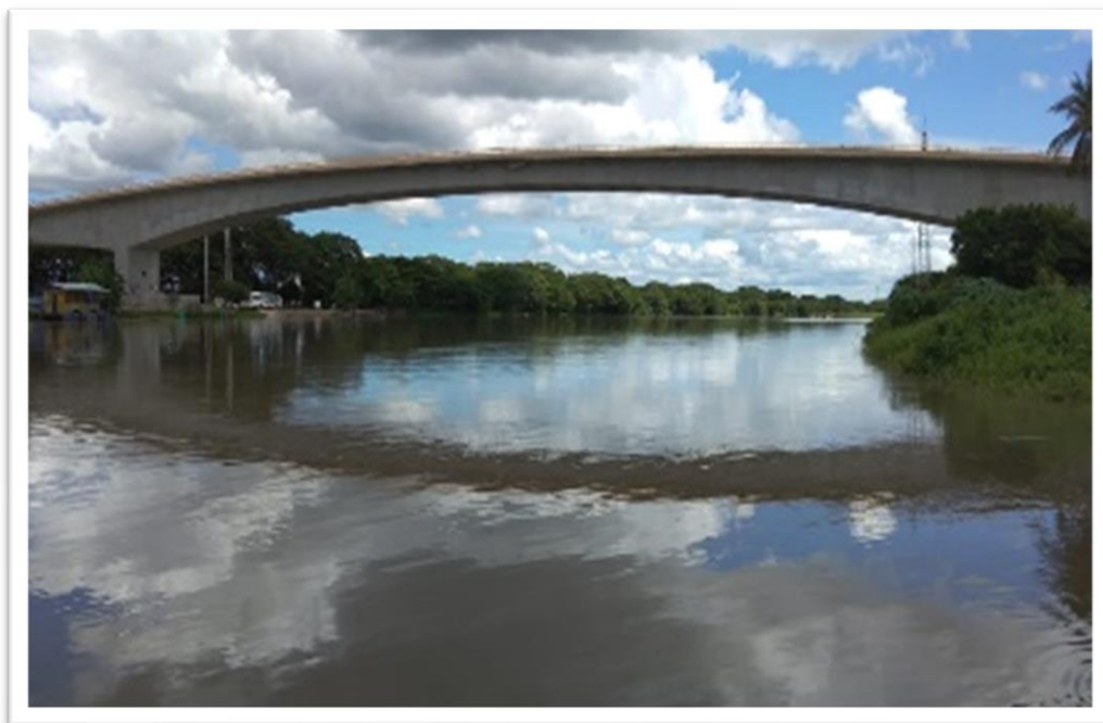
Imágenes No.68. imágenes y evidencias construcción de un puente sobre el canal del dique entre los municipios de San Estanislao de Kotska y Soplaviento FUENTE: Secretaría de Infraestructura
