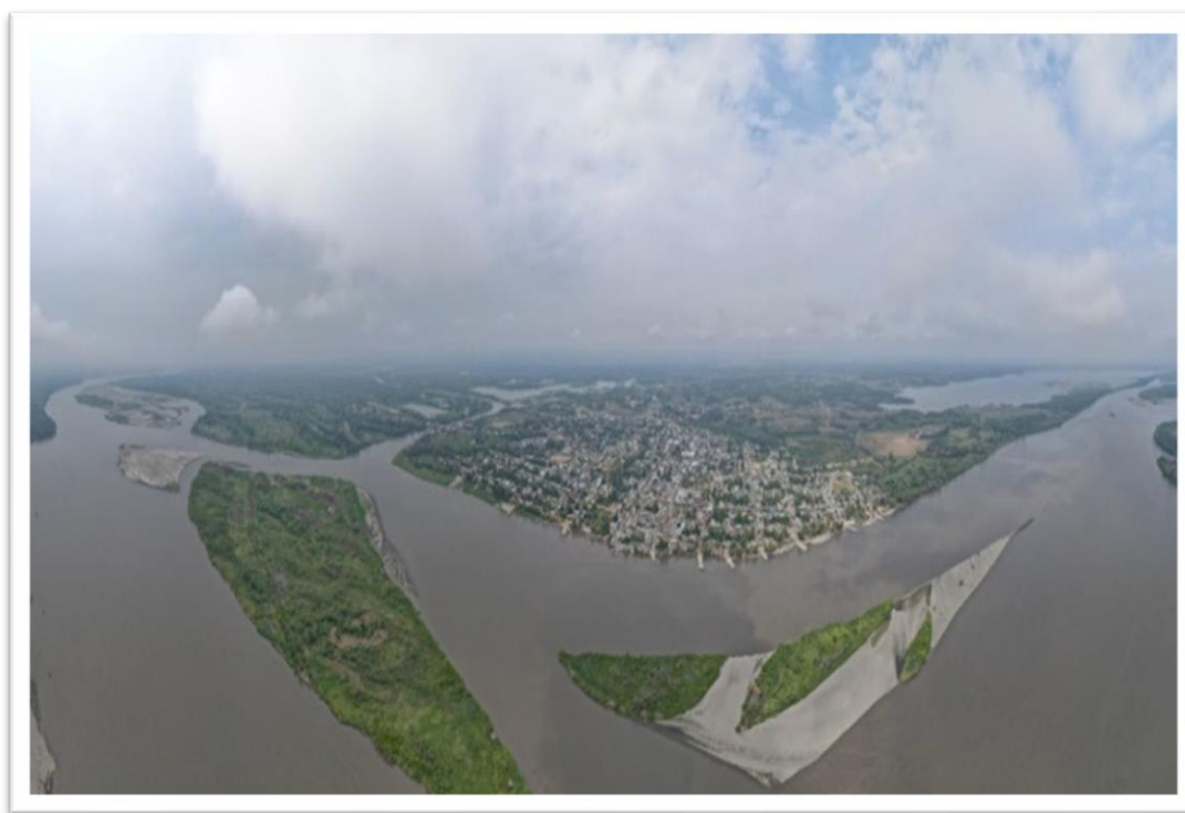
Imágenes No.36 evidencias fotográficas medidas de adaptación y reducción para el control de erosión e inundación entre el magdalena medio y la desembocadura del río cimitarra en el Departamento de Bolívar. FUENTE: Secretaría de Infraestructura
