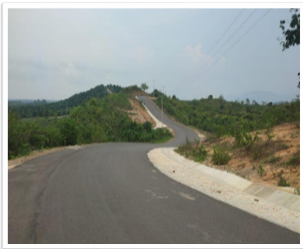
Imágenes No.78. Imágenes y evidencias del mejoramiento de la vía que conduce del corregimiento de Nueva Esperanza
