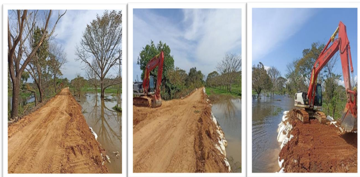
Imágenes No.55 Evidencias fotográficas de obras de mitigación para la respuesta de la emergencia generada por la ocurrencia de la temporada de lluvias en el municipio de Talaiqua Nuevo, Departamento de Bolívar
