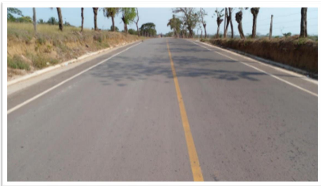
Imágenes No.74. Imágenes y evidencias del mejoramiento del tramo comprendido entre Camilo Torres y Barranca Yuca FUENTE: Secretaría de Infraestructura
