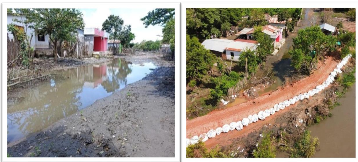
Imágenes No.57. Evidencias fotográficas de obras de mitigación para atención de emergencia en el corregimiento de Retiro y puntos críticos en el Jarillón Guazo- Retiro, en el municipio de Magangué, Departamento de Bolívar
