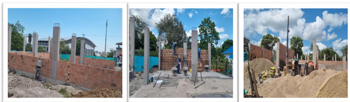
Imágenes No.43. Evidencias fotográficas de la construcción de un centro de formación y desarrollo minero en el municipio de Santa Rosa del Sur, Bolívar.
