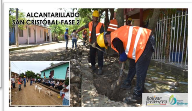
Imágenes No.29. Collage de trabajos de los alcantarillados Carmen de Bolívar, Mompós, San Juan, San Estanislao, Calamar y San Cristóbal – Fase 2. FUENTE: Aguas de Bolívar E.S.P.
