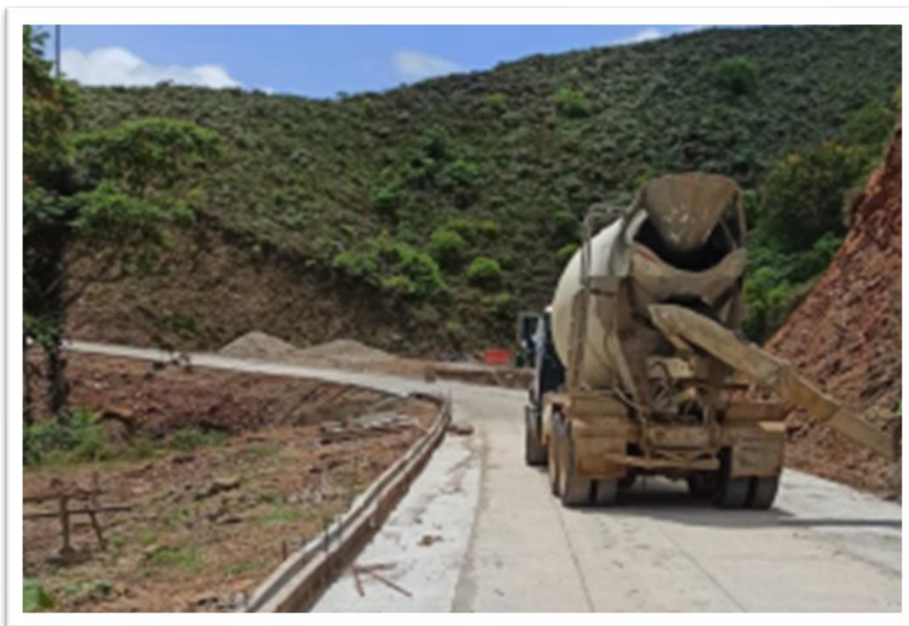
Imágenes No.77. Imágenes y evidencias del mejoramiento de la vía que conduce casco urbano del municipio de Montecristo a Puerto Venecia municipio de Achí
