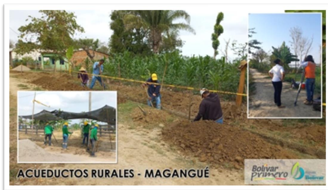
Imágenes No.30. Imágenes y evidencias de trabajos en acueducto de Magangué. FUENTE: Aguas de Bolívar E.S.P.
