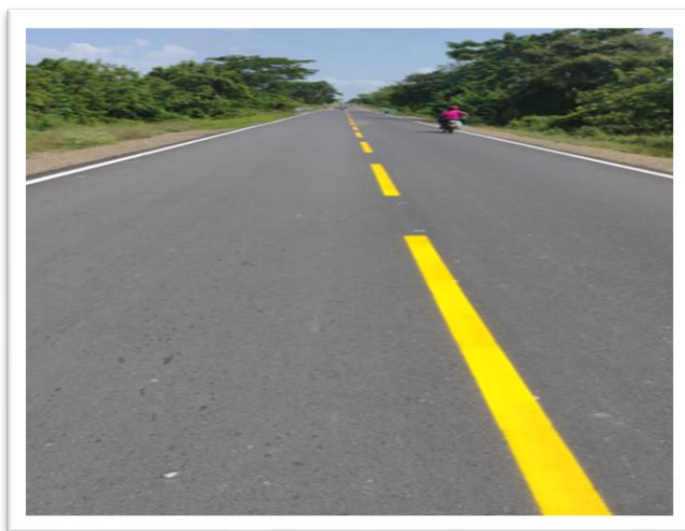
Imágenes No.39 evidencias fotográficas rehabilitación de la vía que comunica, el municipio de mahates con la intersección – ruta nacional 25bl02 carreto-cruz del viso en el Departamento de Bolívar
