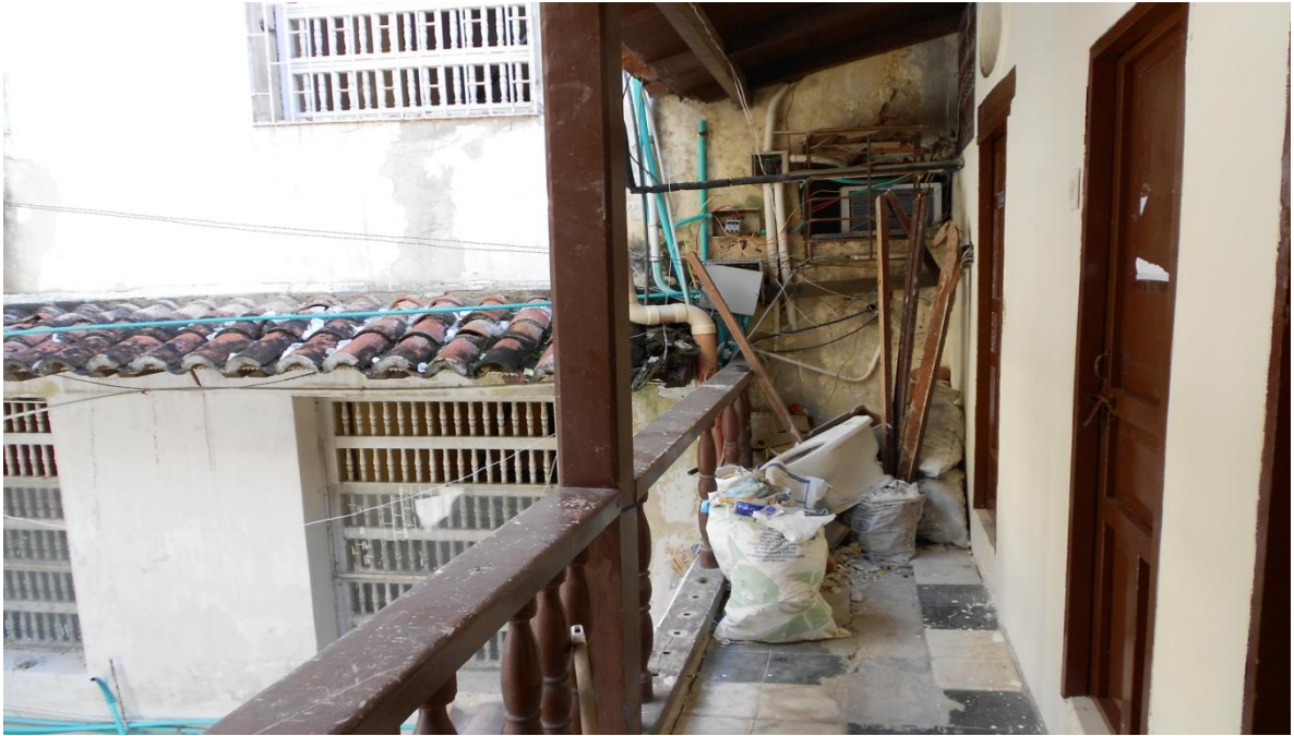
Balcón Interno de acceso a los baños
