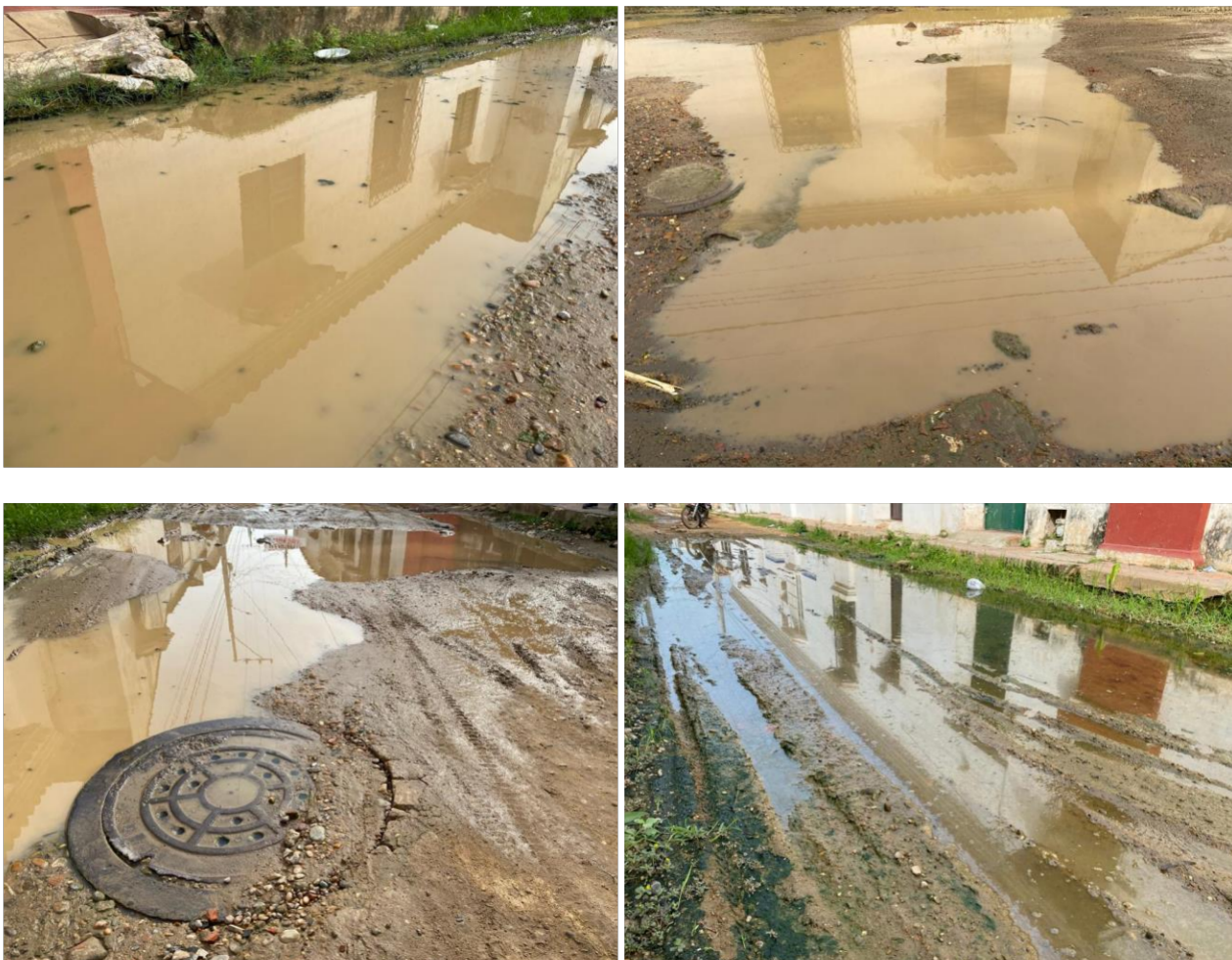
Imagen: afectaciones sobre el tramo de la calle 16.
